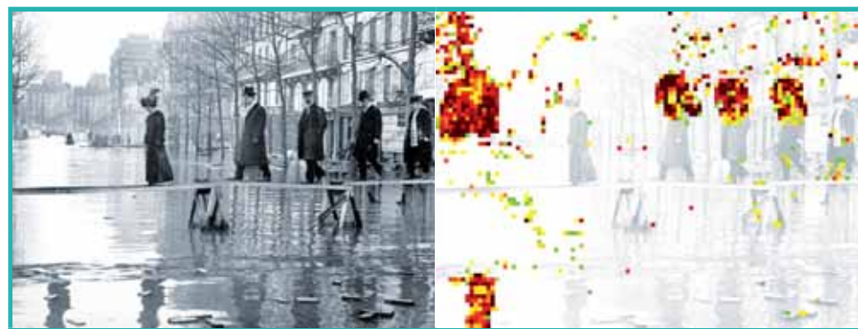
Fig. 14 : Photographie retouchée et détection des différences JPEG
